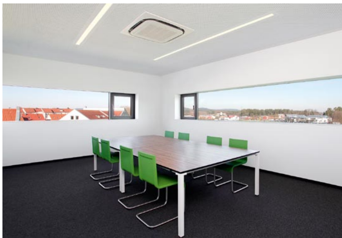
Besprechungsraum mit Roundflow-Kassette
