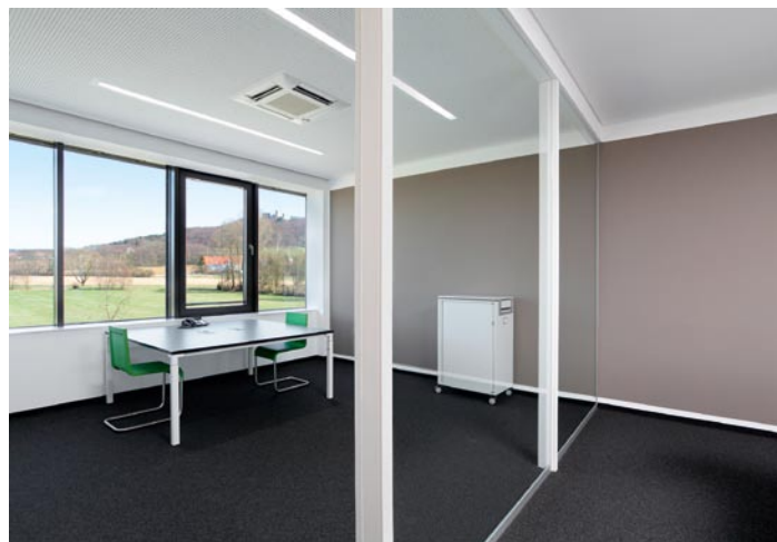
Büro mit Innengerät im Rasterformat
